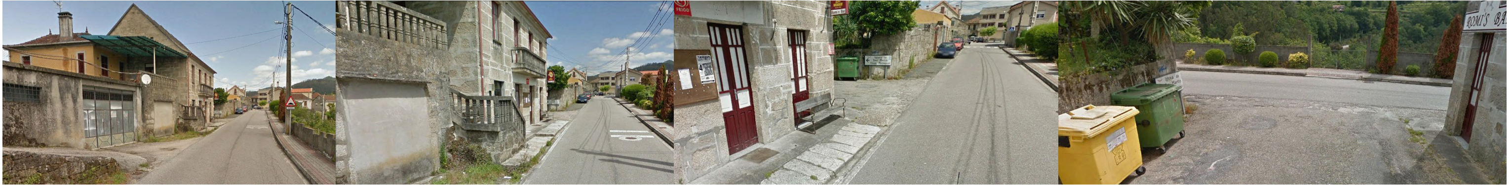
1. Vista dun tramo da estrada de unión coa praza de Barciademeira. Á esquerda arrinque da rampa de acceso ao cemiterio e caserío destinado a bar.
