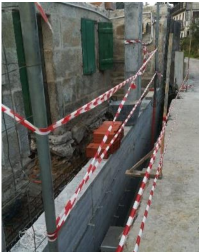
Ejecución de muro de HA
