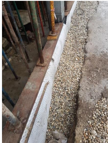
Drenaje e impermeabilización
