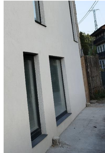
Estado final (reposición camino)
